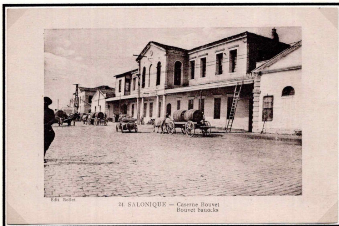
Στρατιωτικές εγκαταστάσεις στο λιμάνι.
